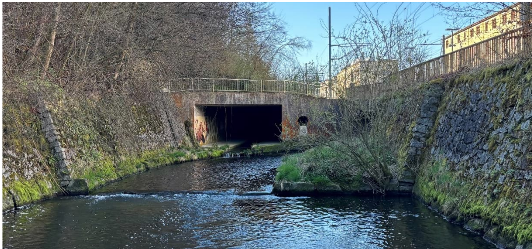
Abbildung 23: Hochwasserentlastung im untersten Teil des Abschnitts HWE_Kemp
