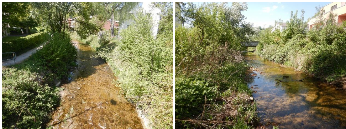
Abbildung 37: Abschnitt Rep_Bir_13 von Brücke Zürcherstrasse (links) und ca. in der Mitte des Abschnitts (rechts), Blick in Fließrichtung
