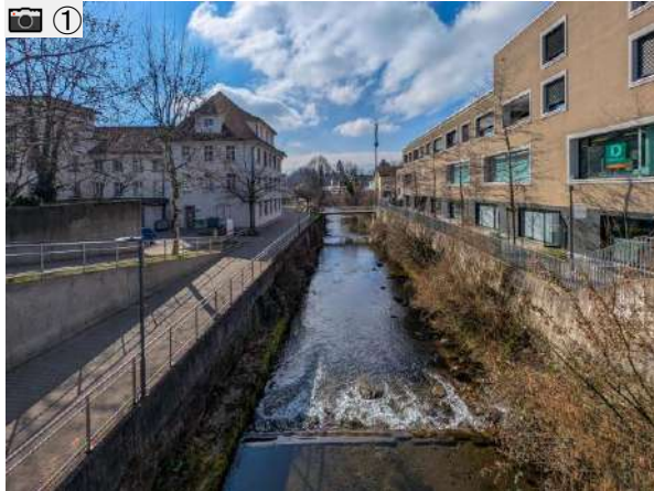
Blick von Brücke Dorfstrasse in Fließrichtung
