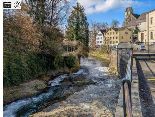
Blick in Fließrichtung
