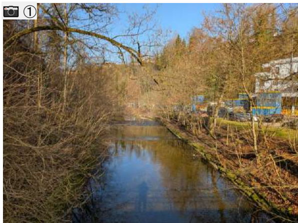
Blick von der Brücke in Fließrichtung
