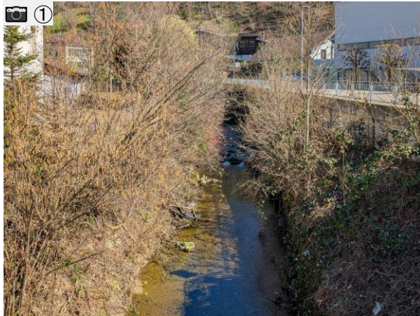
Blick von der Brücke gegen die Fließrichtung
