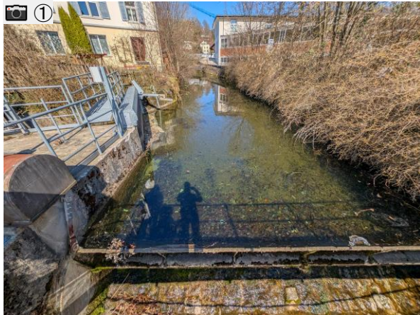
Blick vom Wehr gegen die Fliessrichtung
