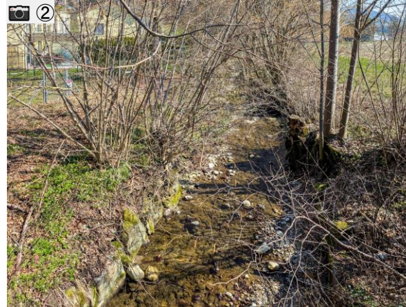
Blick vom Durchlass in Fliessrichtung
