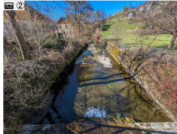
Blick von der Brücke in Fließrichtung
