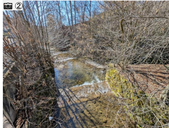
Blick von der Brücke in Fließrichtung
